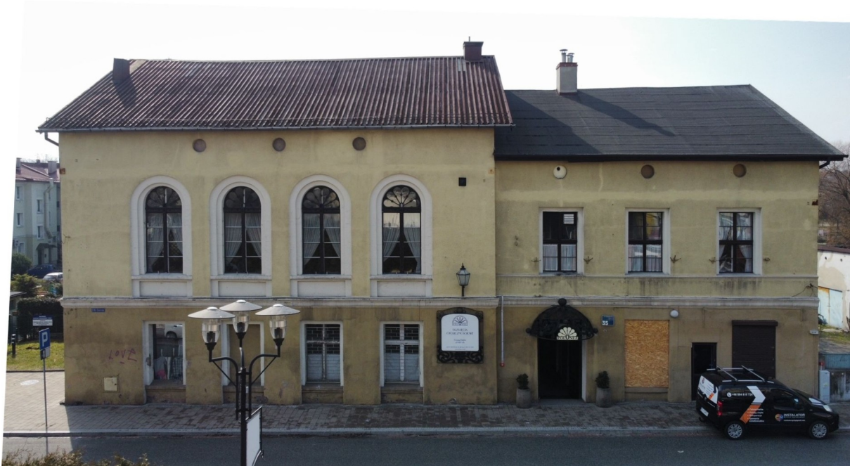
Elewacja północna, uliczna – część wysoka i część niska
