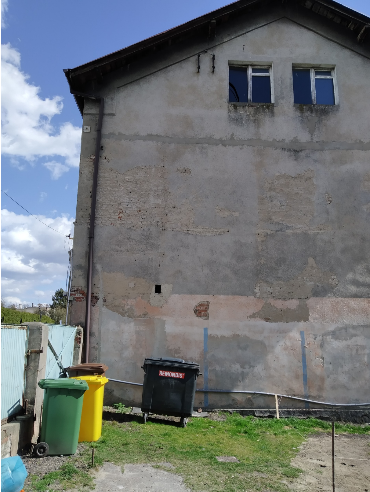
Elewacja zachodnia w miejscu wyburzonego budynku
